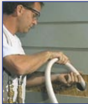
EXISTING STUD WALLS
